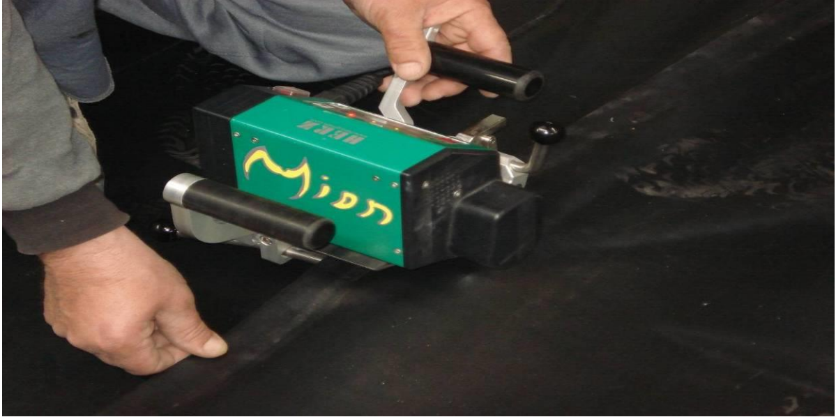
Otomatik Kaynak Robotu ile Kaynak Yapılması
