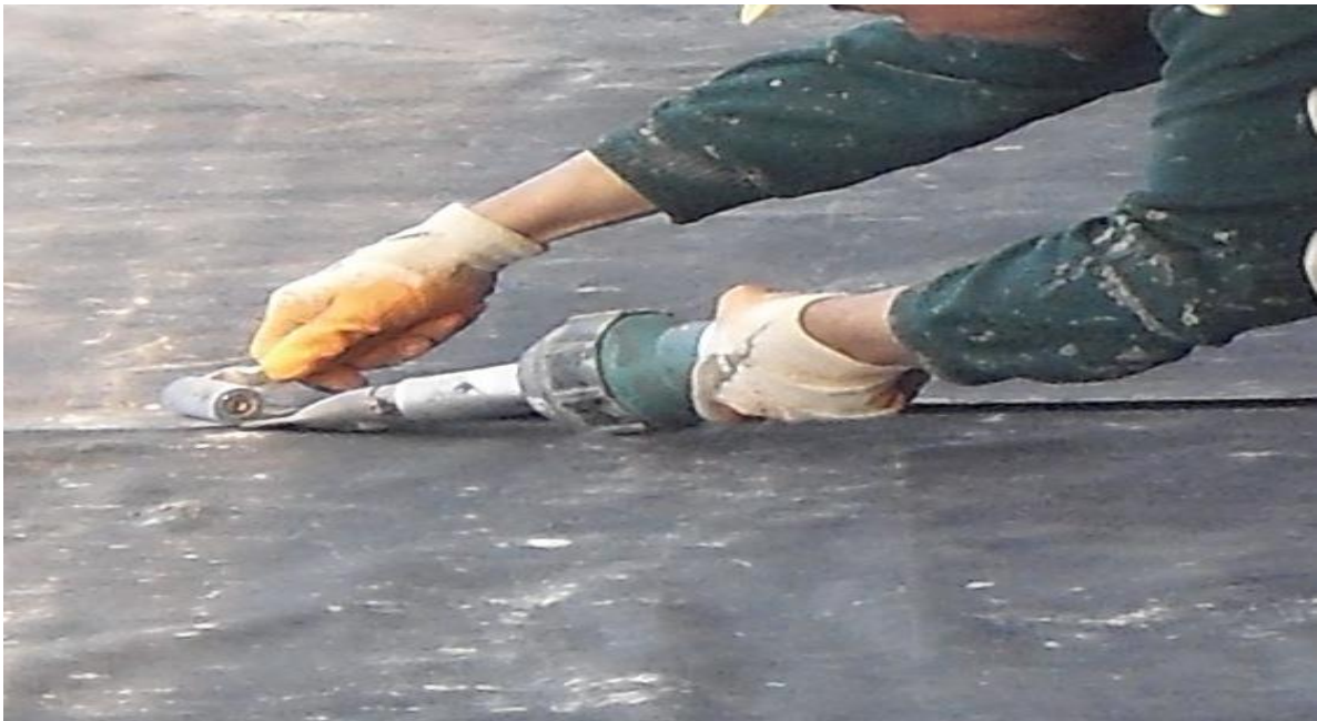
El Kaynak Makinesi ile Yapılan Bir Uygulama
